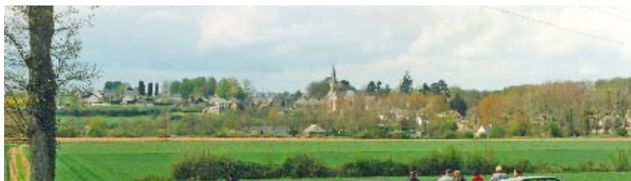
L'appartenance à la vallée apporte une grande variété de sols aux caractéristiques hydrauliques contrastées
